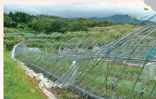
台風で被害を受けたパイプハウス
