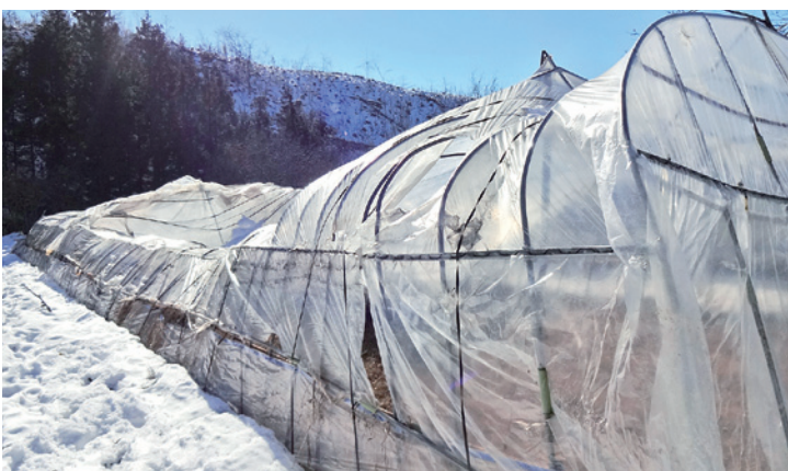
▶雪の重みでパイプハウスが倒壊
