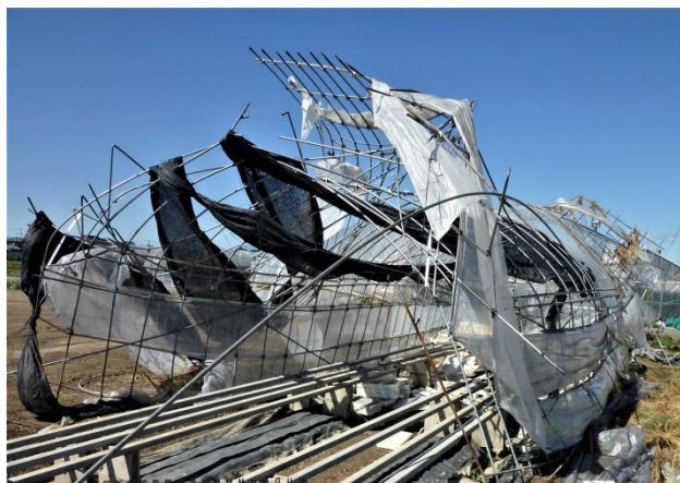
台風被害の様子
